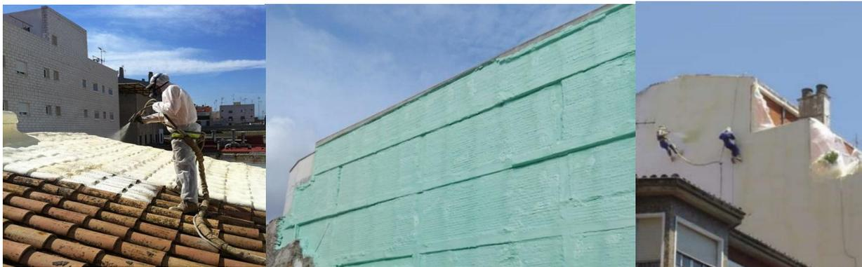
Fig. 19, 20 y 21. Poliuretano proyectado sobre medianeras expuestas y techos.
