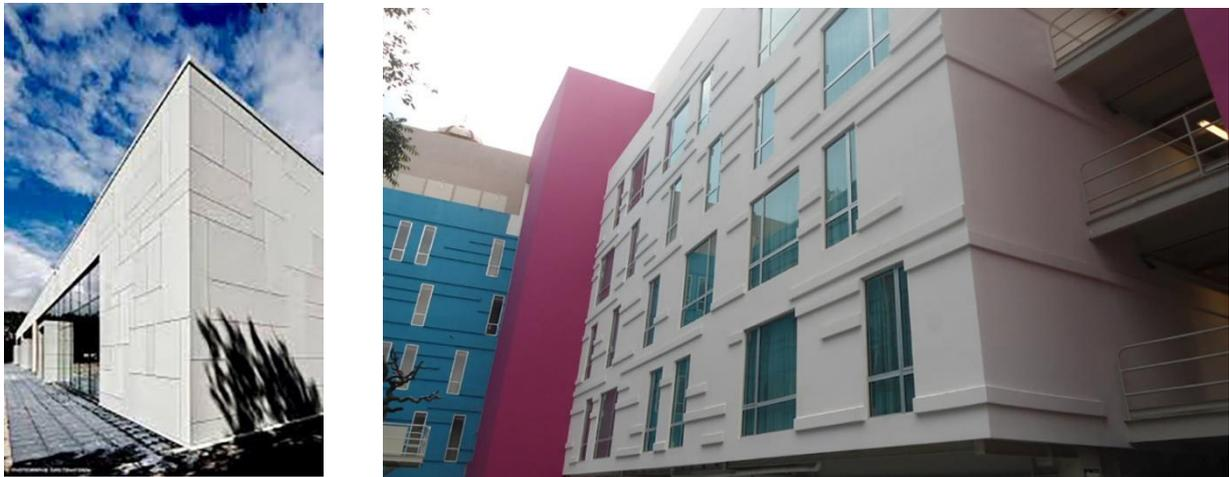
Fig. 17 Y 18. Ejemplos de acabados con sistema EIFS.
