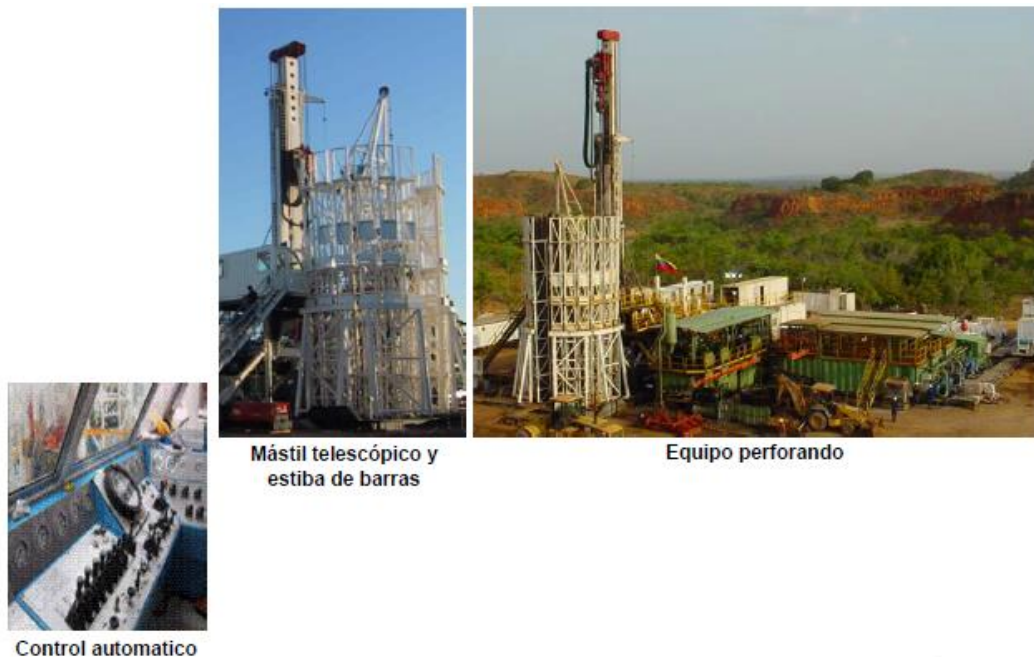
Ilustración 14. Equipos de perforación.
