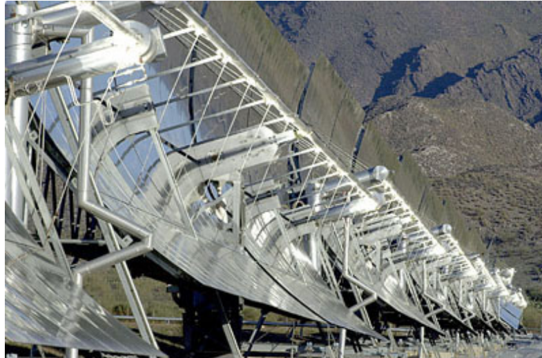
Figura 2.2.3-2. Sistema solar térmico de media temperatura.
