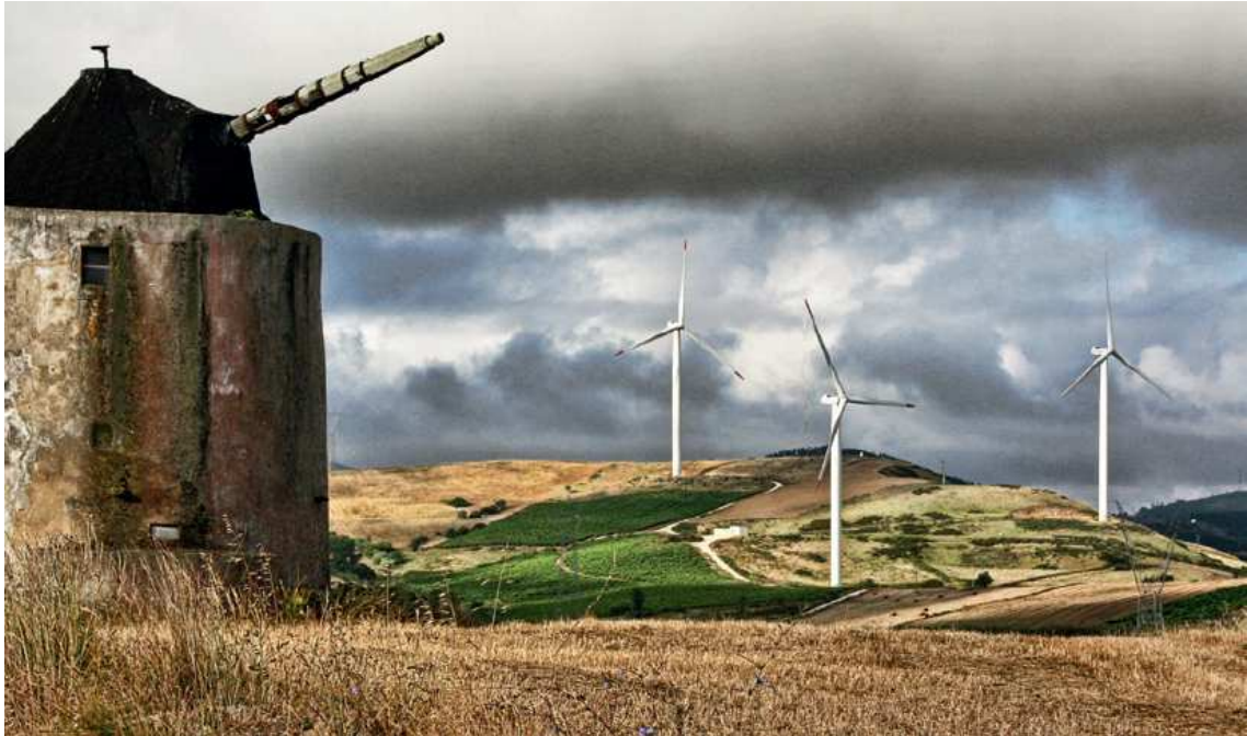
Figura 5.3.3.a Parque Eólico Terrestre
