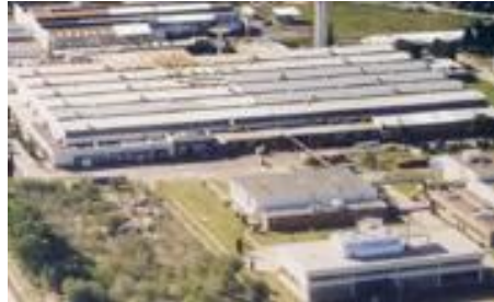
Figura 2. Centro Industrial Córdoba.
