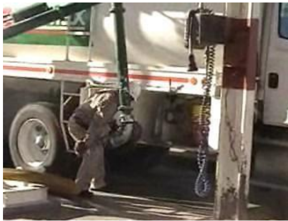
Figura 3.1 Brazo de carga y conexión permisivo a tierra, isla de llenado
