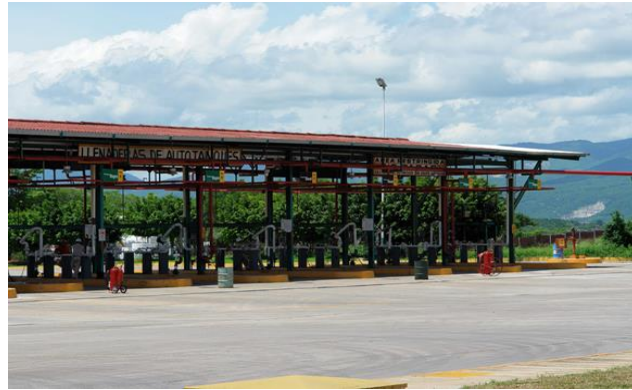
Figura 2.5 Área de llenaderas (islas) en la TAR.
