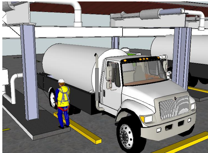
Figura 4.16 Operador desconecta la conexión brazo-auto tanque (automático)
