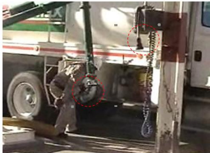
Figura 2.6 Brazo de carga y conexión permisivo a tierra en la isla de llenado.
