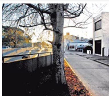
TUNEL EL PASO BAJO NIVEL DE CONSTITUYENTES Y LAS CASAS DE LOS VECINOS.
