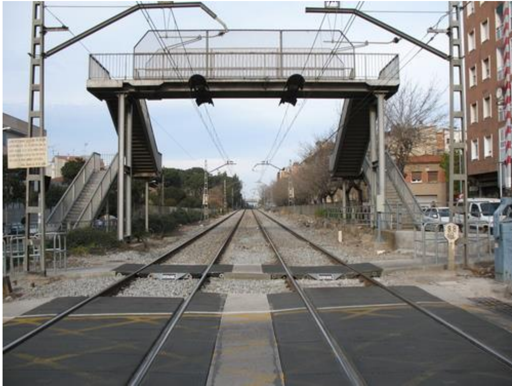
Figura 1.5.7-1: Paso a nivel cerca de San Feliú de Llobregat, Cataluña [34]
