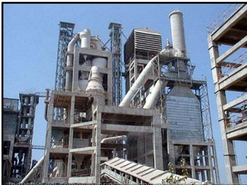
*Figura 9 –Horno cementero alimentado con CDR*
