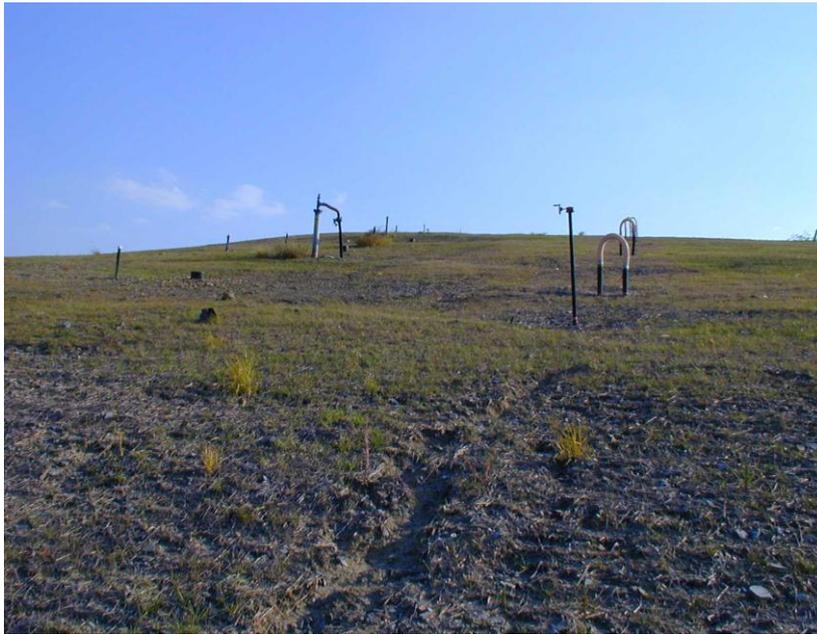
Figura 10.4-1: Extracción de biogás de un relleno cerrado [ISWA]
