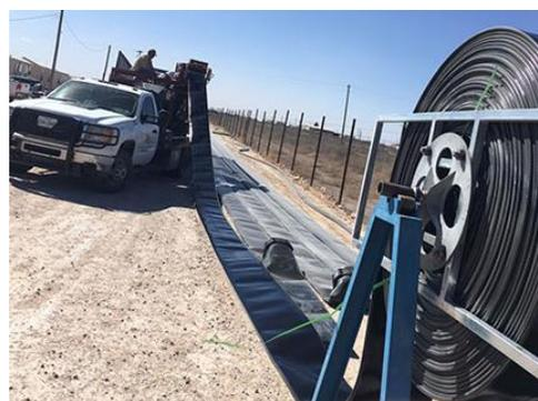
Figura 4. Montaje de flexi pipe
