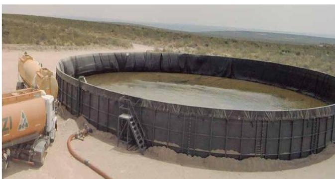
Figura 3. Acopio de agua en tanque australiano.
