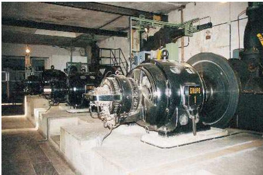
ILUSTRACIÓN V-1. GRUPOS DE LA TURBINA DE LA CENTRAL PATALA EN ESPAÑA
