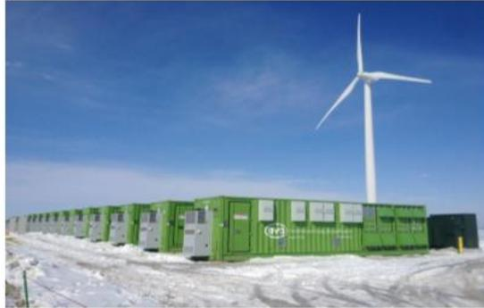
A diferencia de Tesla, BYD emplea contenedores para el montaje de sus sistemas de almacenamiento. Este contenedor alberga las baterías, junto a su sistema de control y la electrónica de potencia necesaria para entregar 400 V en corriente alterna a 50 Hz.
