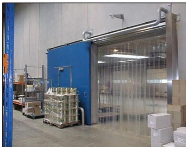
*Figura 105: Cortina sanitaria de PVC usada para separar líneas de producción.*
