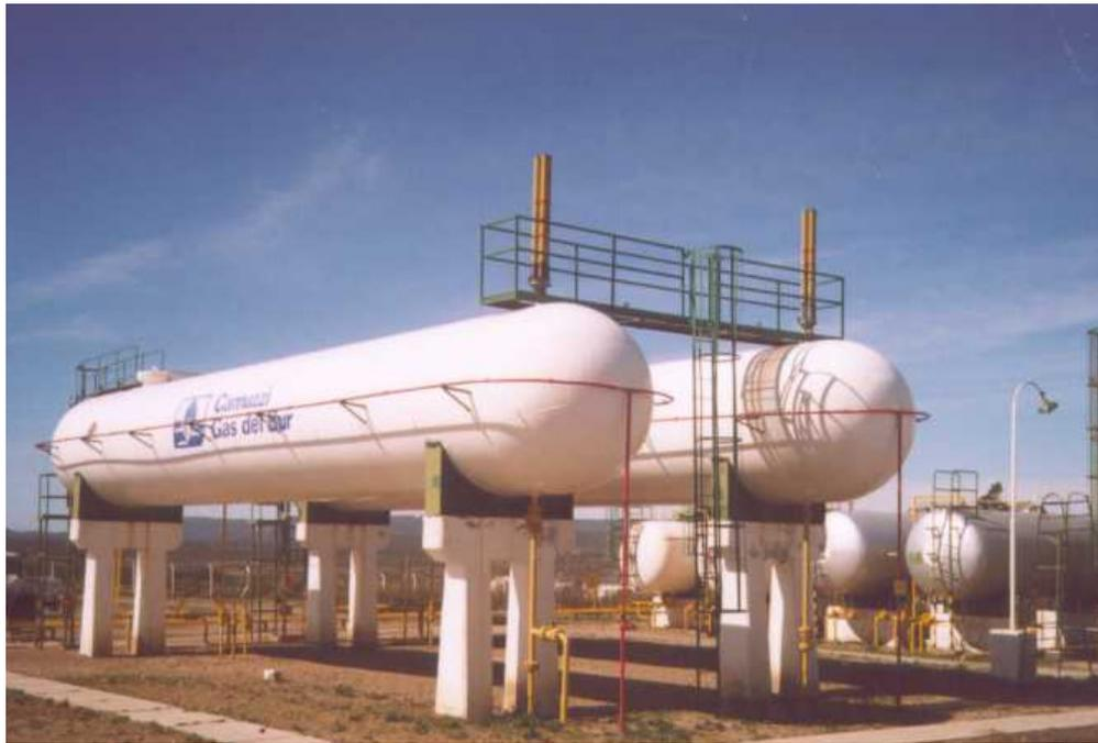
**Figura 3.20.** Tanques de almacenamiento de propano.
