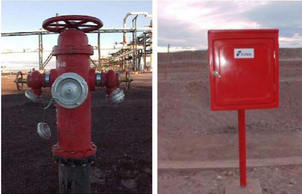
**Figura 3.27.** Hidrante y gabinete para manguera.
