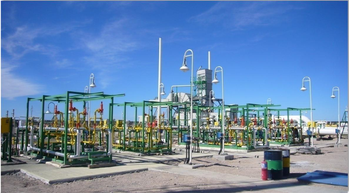
Respecto a la presión, éstos aseguran la mínima que requieran los motores y la turbina para su correcto funcionamiento y a la vez, no permitirán que se exceda la máxima de diseño de los mismos. También incluyen filtros para acondicionar el gas a las especificaciones que requiere tanto el TC como el MG.
