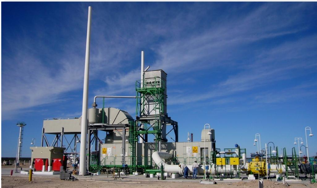
Como se explicó anteriormente, la función de los Turbo-compresores es elevar la presión al gas que estos impulsan. La presión va disminuyendo por la propia circulación del gas por la cañería debido a los siguientes dos tipos de pérdidas:
