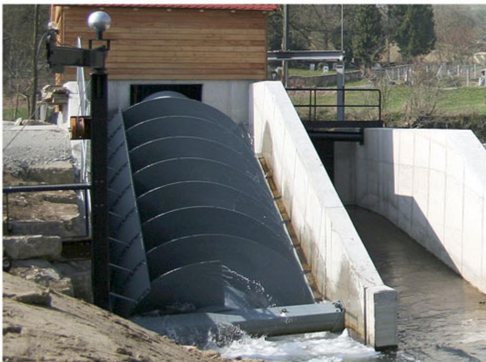
**Figura 4.1.3.** *Ejemplo de sistema de generación en Europa. Potencia entregada 83 kW, Altura neta 2.85 m, caudal de diseño 4 m<sup>3</sup>/s (Fuente: Ritz-Atro).*
