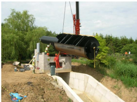
**Figura 4.4.2.** Ejemplo de montaje de tornillo
