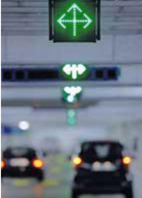
utiliza en el Dot Baires). El sistema indica con luces verdes y rojas a los conductores, por donde hay cocheras vacías (luz verde), y donde no (luz roja). De este modo, se logra que:
