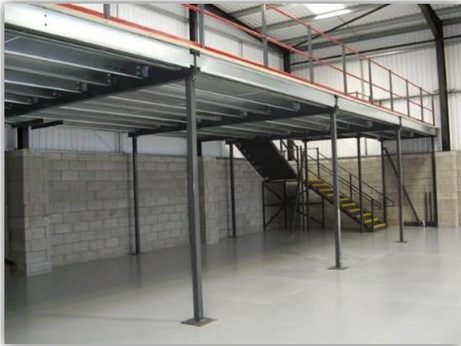
*Figura 6.8. Entre piso metálico.*
