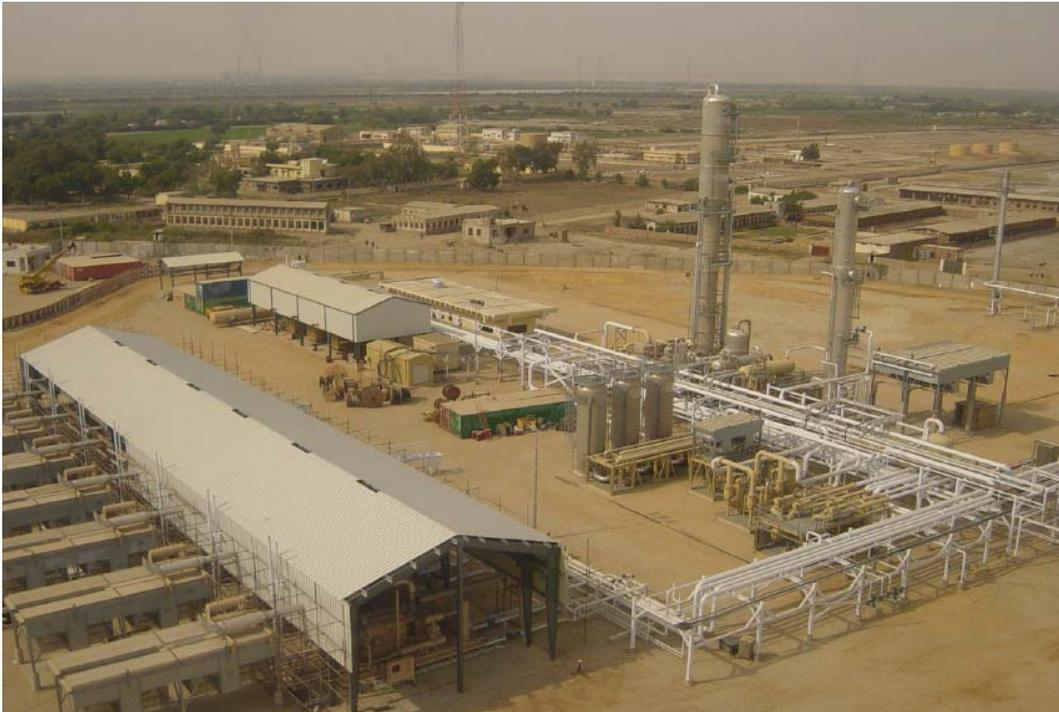
*En la foto se muestra una planta Criogénica capaz de procesar hasta 200 MMSCFD (aprox. 6 MMSCMD)*
