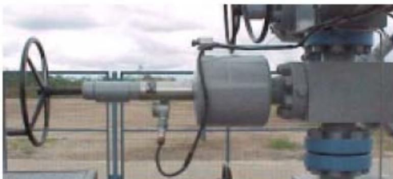
Válvula de seguridad con actuador neumático
