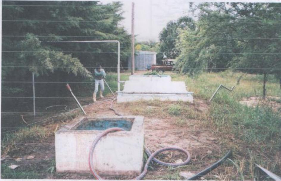
Vista General del Biodigestor de 40 m<sup>3</sup> Terminado y en Funcionamiento, con Agitadores Mnauales
