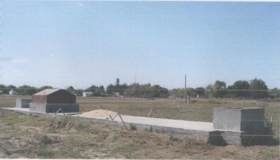
Vista General Exterior de Biodigestor de 80 m<sup>3</sup> de Volumen; con Agitadores Manuales
