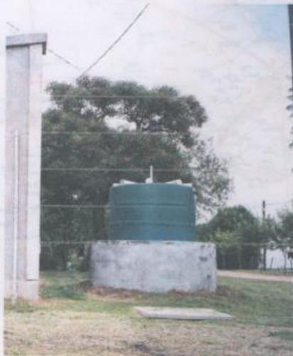
Gasómetro para Acumulación de Biogás
