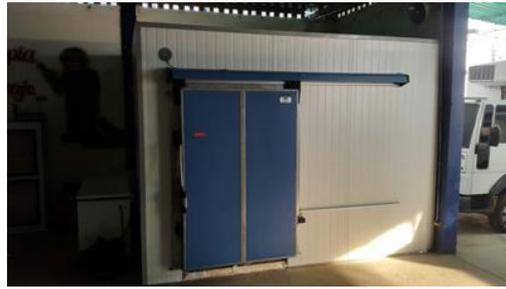
*Figura 2.7: Cámara de mantenimiento de productos congelados*
