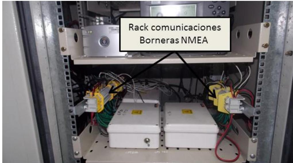
*Ilustración 42 – Borneras de interfaces NMEA 3n rack comunicaciones*
