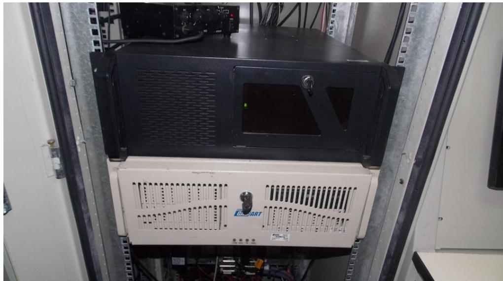
*Ilustración 43 - Servidor principal y de respaldo*
