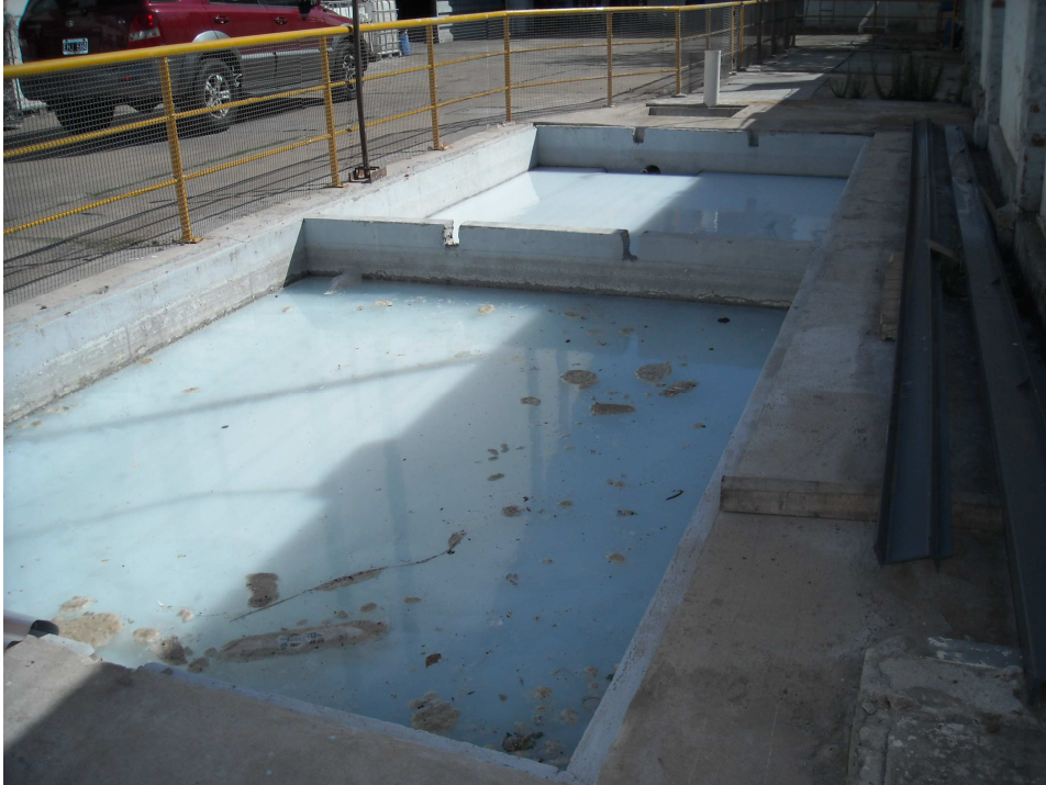
Foto 1. Pileta de ecualización. Foto de planta primitiva de tratamiento.
