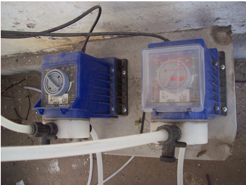
Fotos 12, 13 y 14. Conjunto de tanques dosificadores de ácidos y bases.
