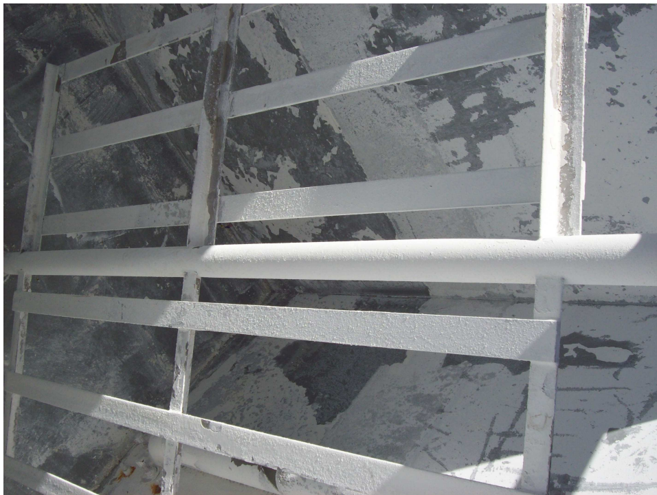
Fotos 5 y 6. Floculador con moto reductor.
