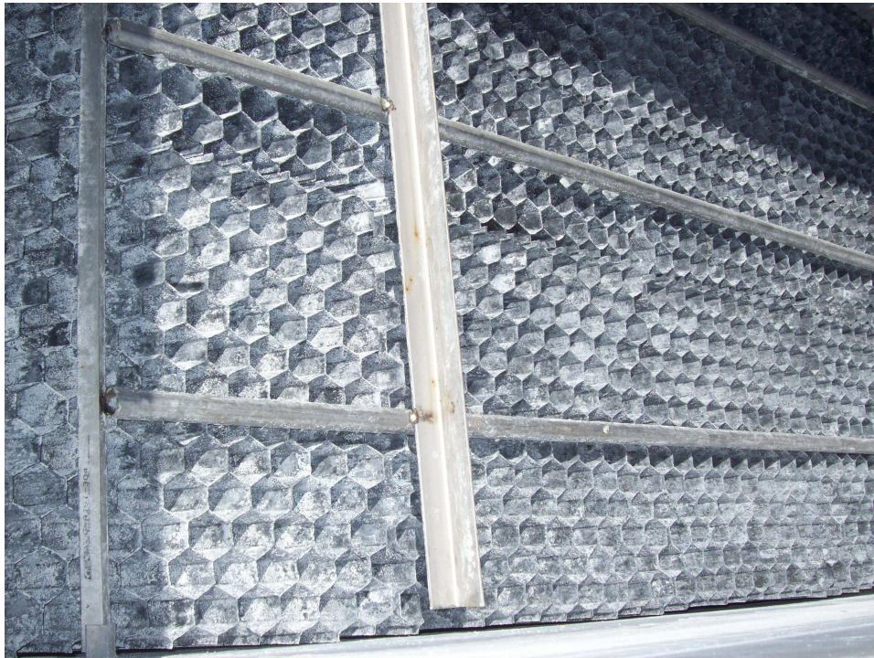
Fotos 7, 8, 9. Sedimentador por placas.
