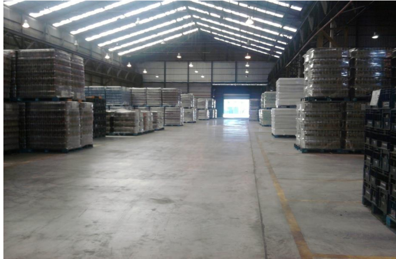
Imagen 2. Interior del depósito San Francisco
