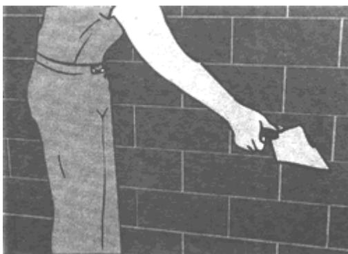
**Figura B.8** Limpieza de derrames de mortero
