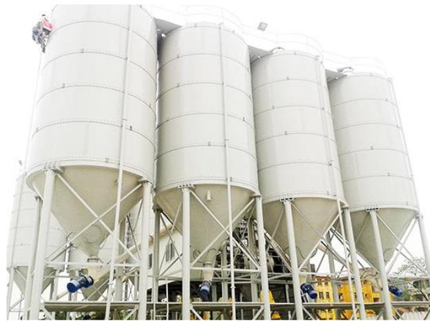
Figura 13.2. Silos cemento de 100 toneladas.
