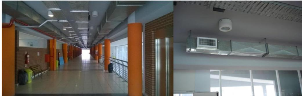
**Figura 2-56: Ductos de calefacción y bandejas de la instalación eléctrica.**
