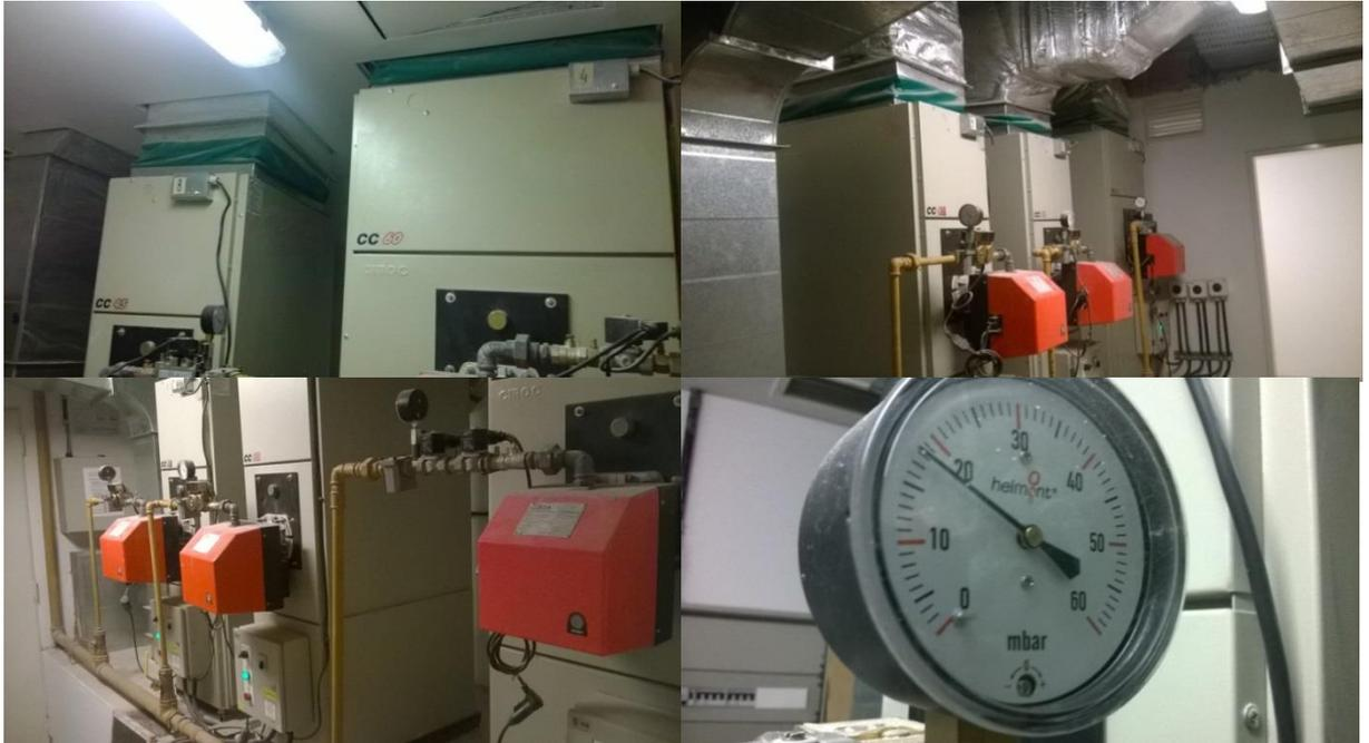
Figura 2-54: Quemadores funcionando con la indicación manométrica correspondiente.
