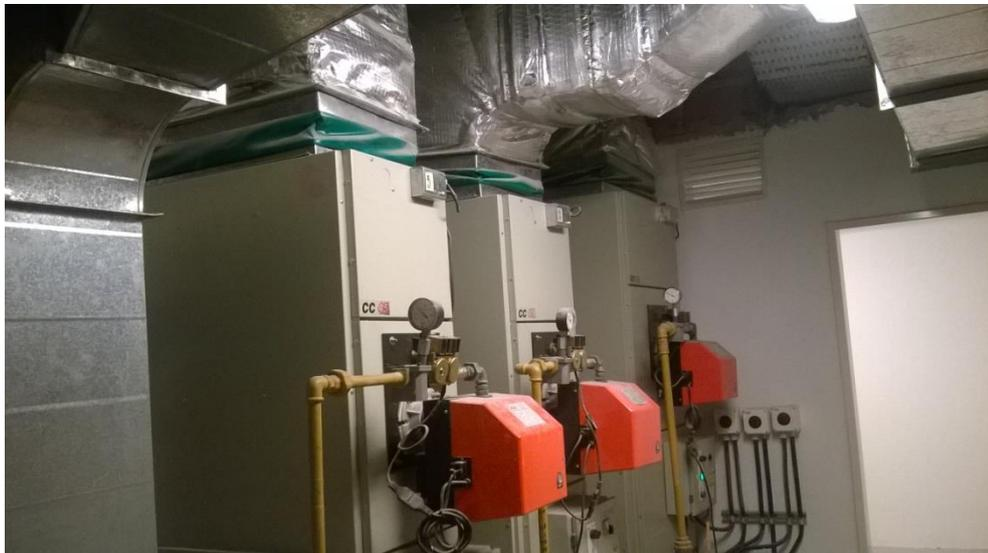
**Figura 6-95: Instalación de los quemadores.**
