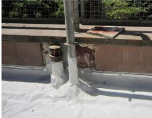
**Figura 6-99: Piso impermeabilizado.**
