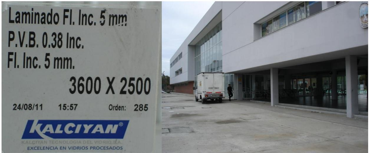
Figura 2-44: Vidriado exterior con datos técnicos.
