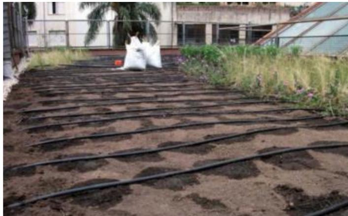
**Figura 6-102: Sistema de riego instalado.**
