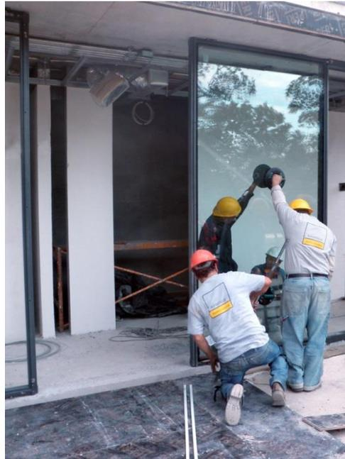
**Figura 6-106: Instalación del vidriado.**
