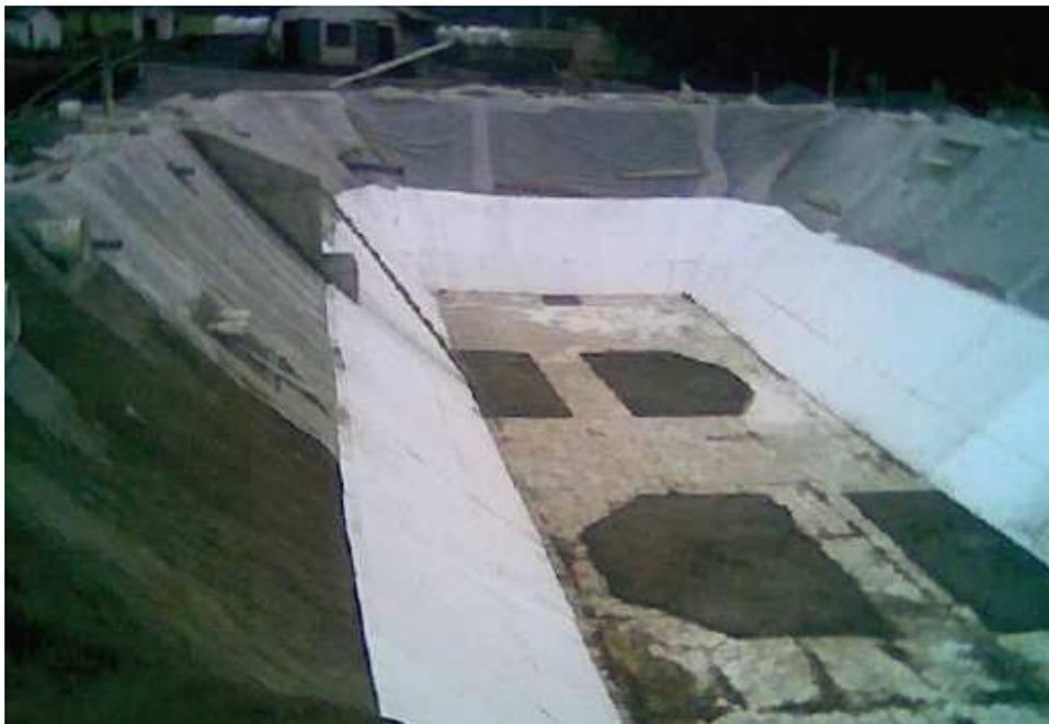
*Figura 15: Recubrimiento de la base con esponjas de poliuretano (Ecuador). Fuente: Aqualimpia.*
