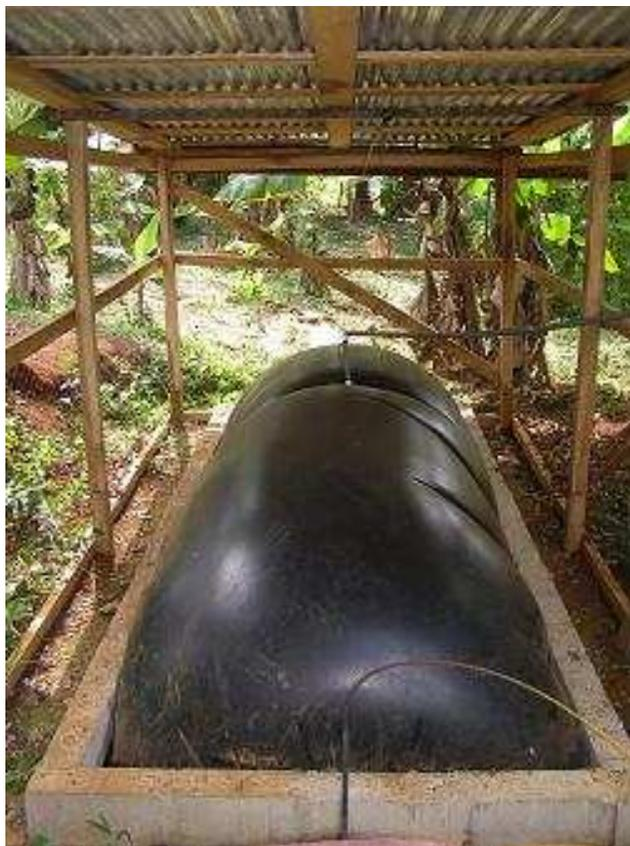
*Figura 6: Biodigestor tubular tipo “Salchicha”. Fuente: Fundación Energizar.*
