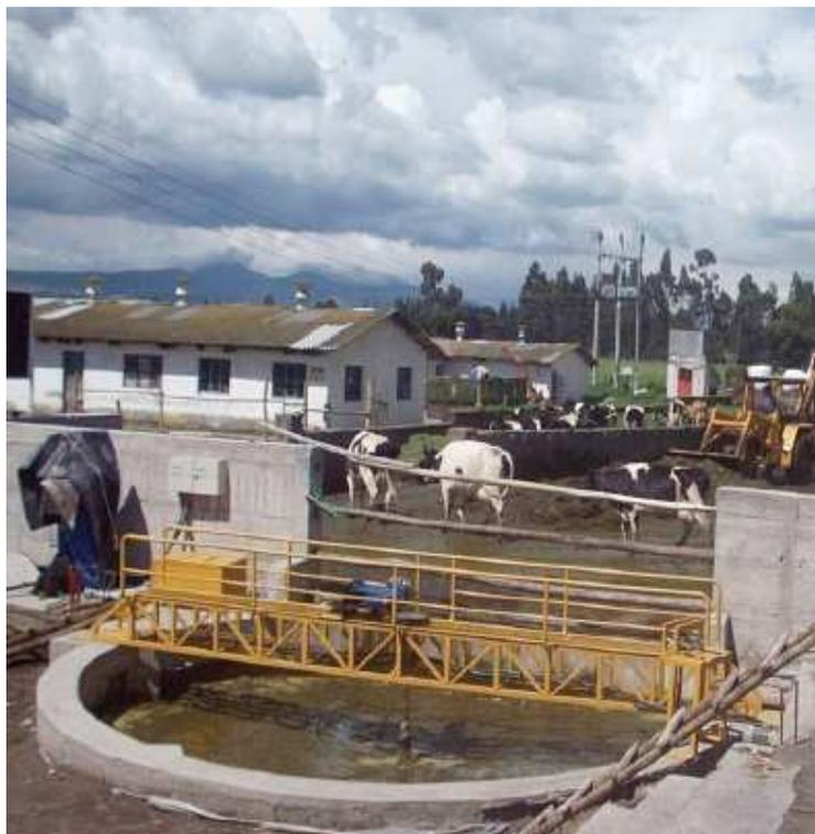
Figura 12: Tanque de mezcla en el extrema del corral (Ecuador). Fuente: Aqualimpia.
