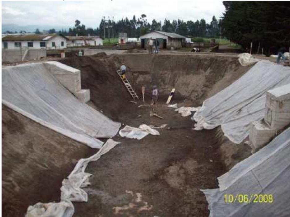
*Figura 13: Recubrimiento de taludes para evitar colapsos (Ecuador). Fuente: Aqualimpia.*
