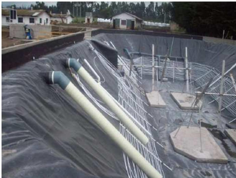
*Figura 14: Instalación de agitares y membrana inferior (Ecuador). Fuente: Aqualimpia.*
