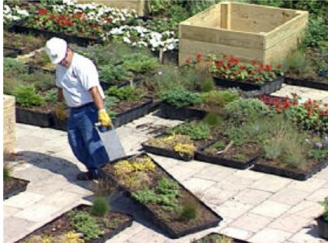
**Figura 4.2-2:** Instalación de un techo verde modular. (Fuente: GreenGrid™)
