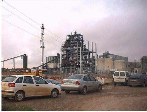
**Figura 4 - Planta de generación eléctrica con orujillo. Villarta de San Juan (Ciudad Real). 16 MWe. Horno de combustible pulverizado**
