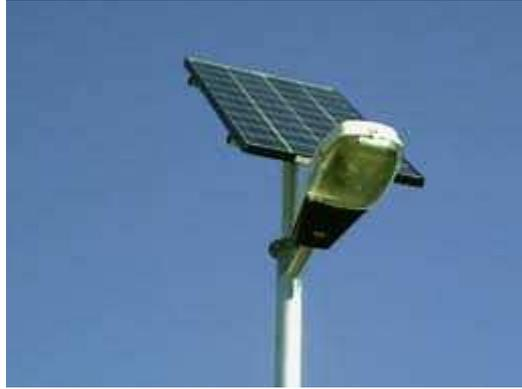
**Figura 24 - Alumbrado público por energía solar**
