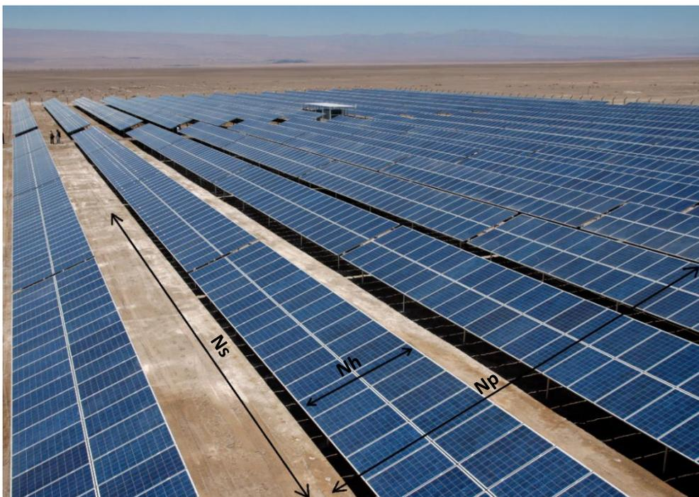
*Ilustración 17: muestra la forma de distribuir paneles siguiendo la conexión serie-paralelo, donde  $N_s$  es el número de paneles en serie,  $N_p$  el número de ramas en paralelo y  $N_h$  la altura de cada fila (en este caso 2).*
