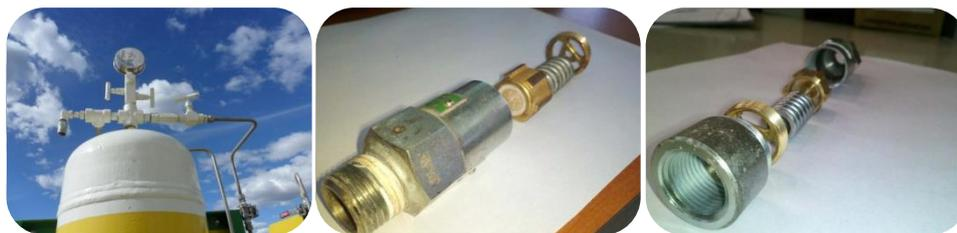
Figura 72. Imágenes ilustrativas de las válvulas que se colocan como seguridad para los tanques de potencia de cada automatización instalada. Por los problemas con estas válvulas se estuvo muy cerca de no poder poner en funcionamiento en la fecha acordada con el cliente la planta compresora Río Colorado II. De allí la importancia de la aplicación de ingeniería concurrente con proveedores, construcciones e ingeniería para reducir los márgenes de error y costos.
