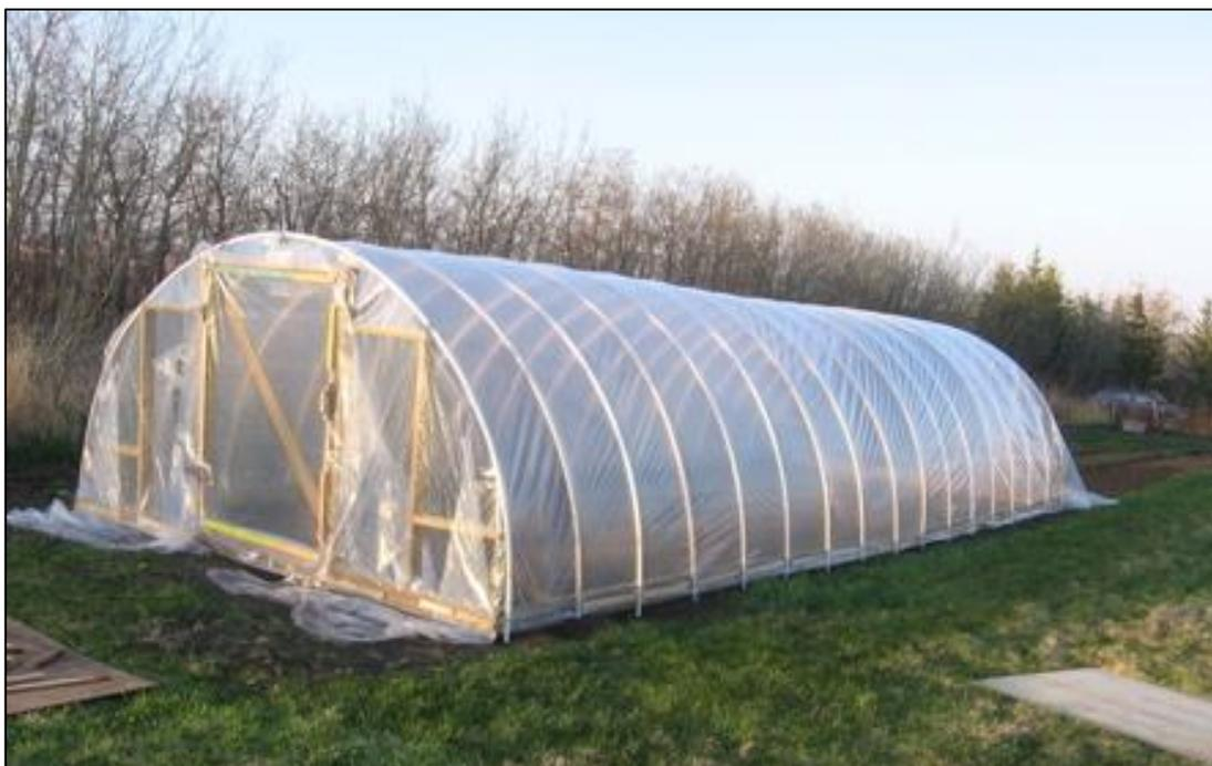
Fig. 22: Invernadero semicircular con estructura de madera (Portal Frutihortícola)
