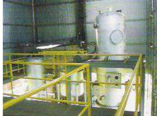
En este proceso, la alimentación, o carga de los Residuos y Biomasa al Reactor se realiza en forma continua y simultánea. Los residuos seleccionados se depositan en la tolva (T-101) y mediante un tornillo (S-101) son introducidos al reactor. En el caso de los aceites, son enviados del tanque (T-102) mediante una bomba (B-101). Como alternativa, se puede mezclar el aceite con los residuos antes de ingresar al reactor y luego mediante un tornillo introducir la mezcla.
