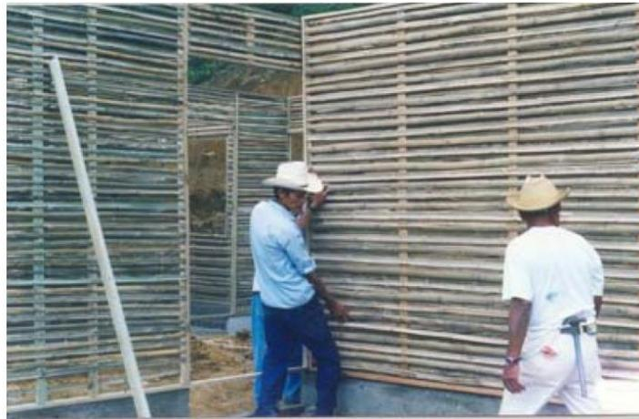
*Ilustración 26. Colocación de paneles de bambú*
