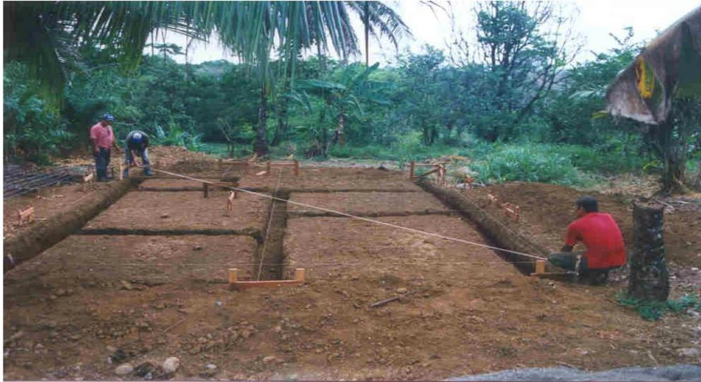
*Ilustración 22. Elaboración de zanjas*
