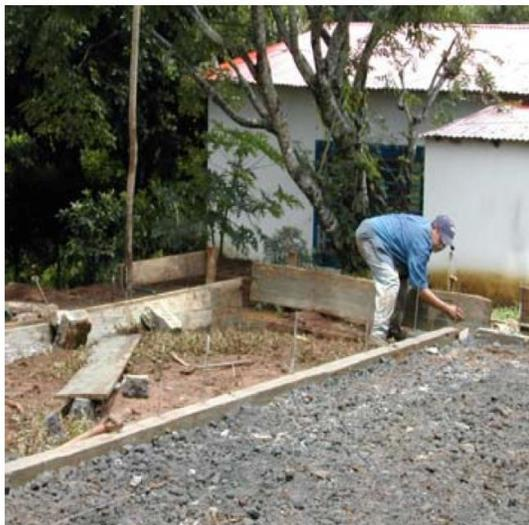
*Ilustración 24. Nivelación con capa de material de cantera*
