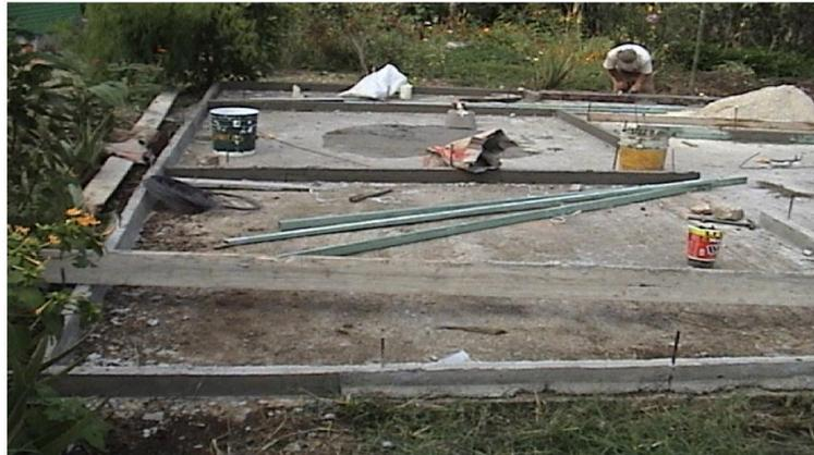
*Ilustración 23. Construcción de cimientos*
