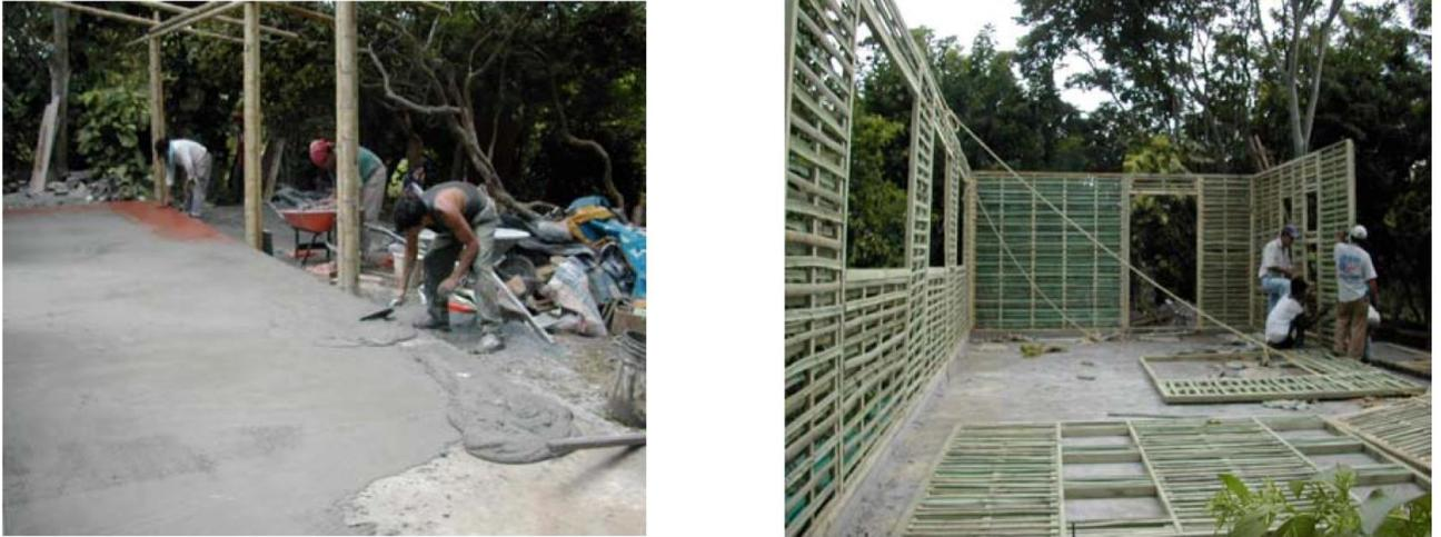
*Ilustración 25. Afinado del piso (izq) y piso colado antes de colocar los paneles (der)*
