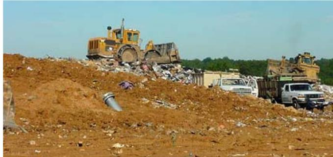
Figura 3.3.6.Fotografía de tareas de compactación en un Relleno Sanitario
