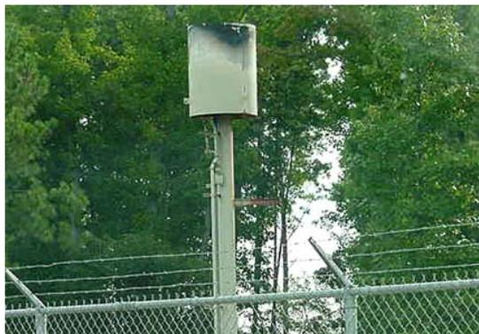
Figura 3.3.11. Sistema de incineración de metano
