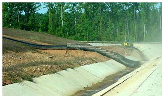
Figura 3.3.7.Fotografía de las cañerías de drenaje
