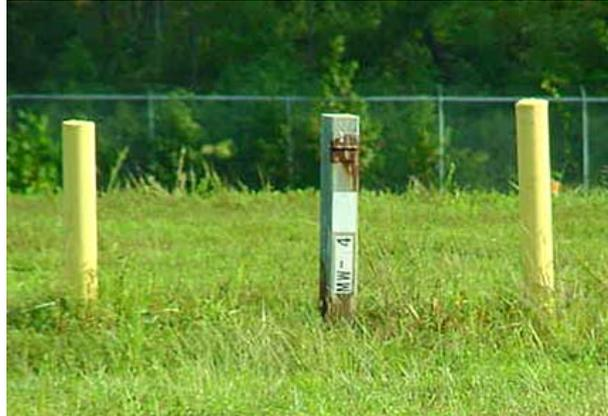
Figura 3.3.14. Estaciones de monitoreo de las napas de agua
