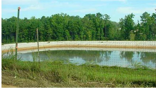
Figura 3.3.9. Fotografía de los estanque de recolección de lixiviado
