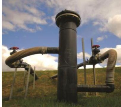
*Figura 2.3.2.4.1. Cabezal de pozo vertical para monitoreo de caudal y presión (International Best Practices Guide for LFGE Projects, 2012).*
