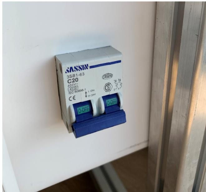
Figura 8.1 Llave termomagnética en posición 'OFF' para el encendido del equipo.
