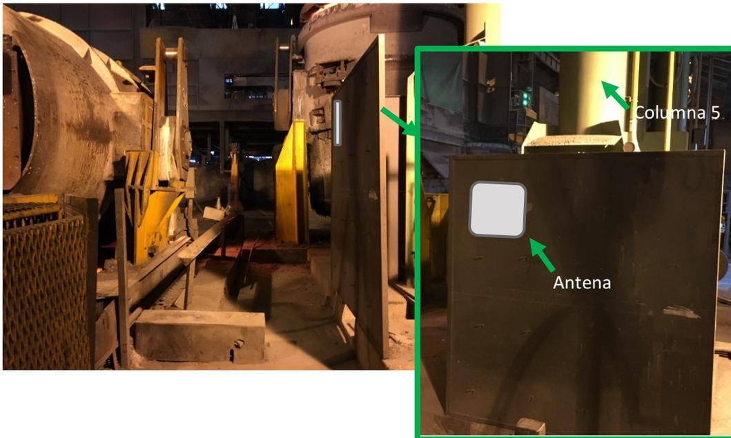
Figura 40: Disposición de antena en estación de precalentador horizontal 4
