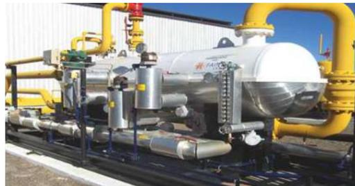
Cada Batería contará con un separador de control de 250.000 Sm<sup>3</sup>/d de capacidad.
