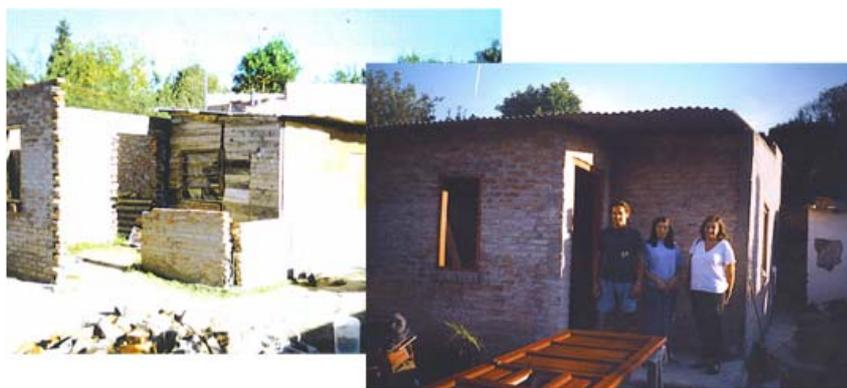
**Figura 3:** Ejemplo de una construcción progresiva de la pared. Foto gentileza de la Fundación Sagrada Familia
