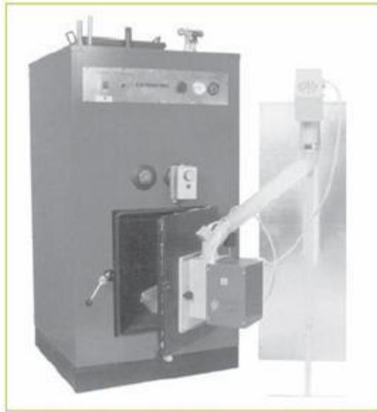
Figura 24 Quemador de pellet aplicado a una caldera de gasóleo
