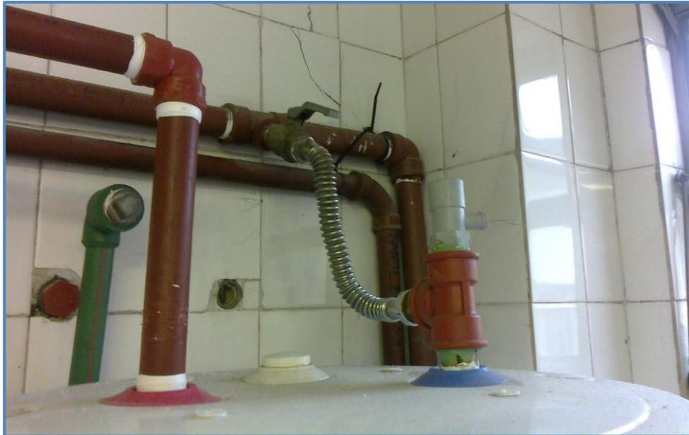
Figura 14 – Detalle de la entrada original de agua fría al termotanque.
