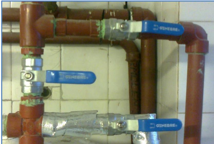
Figura 22 – Posición de las válvulas que incorpora el colector solar al sistema de calentamiento de agua.
