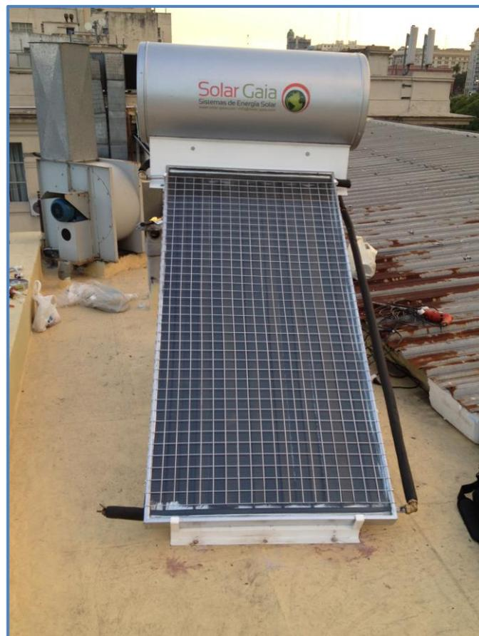
Figura 17 - Vista frontal del colector solar en el momento de la instalación.
