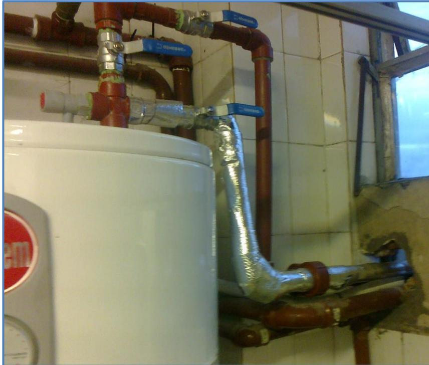
Figura 18 - Vista desde el interior de la nueva tubería instalada, que incorpora el colector solar al sistema.
