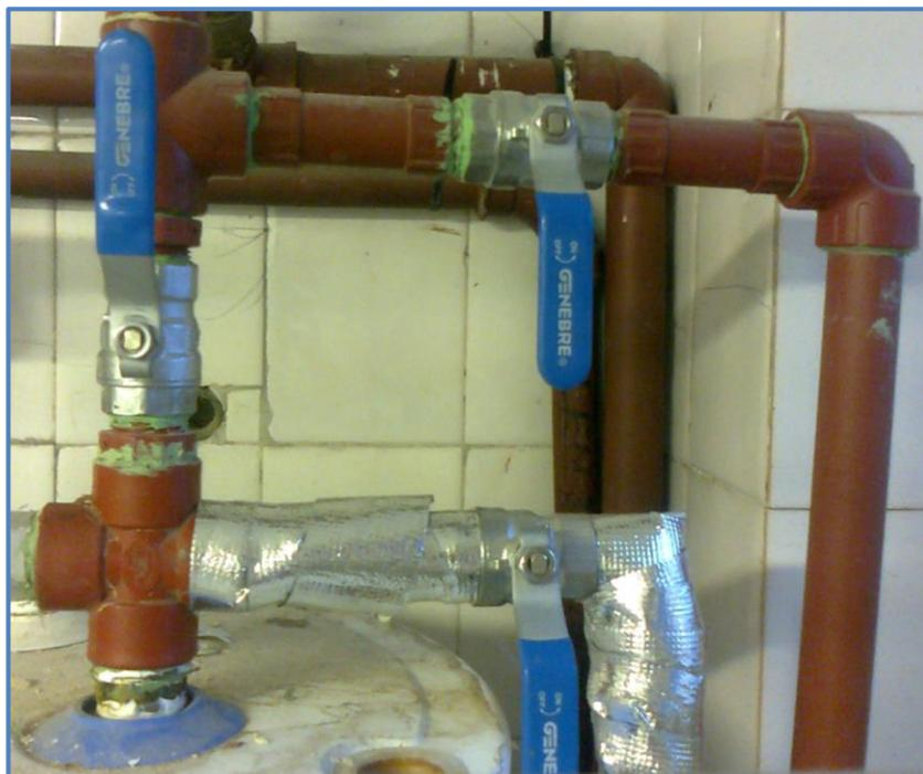
Figura 23 – Posición de las válvulas que aísla el colector solar al sistema de calentamiento de agua.
