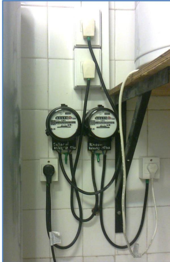
Figura 20 – Vista de los medidores de luz instalados para cuantificar el consumo eléctrico.
