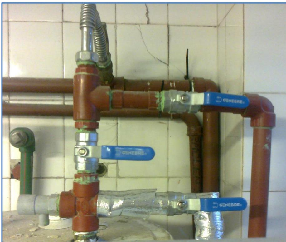
Figura 19 – Detalle del sistema de válvulas colocadas, que permiten incorporar o aislar el colector solar.
