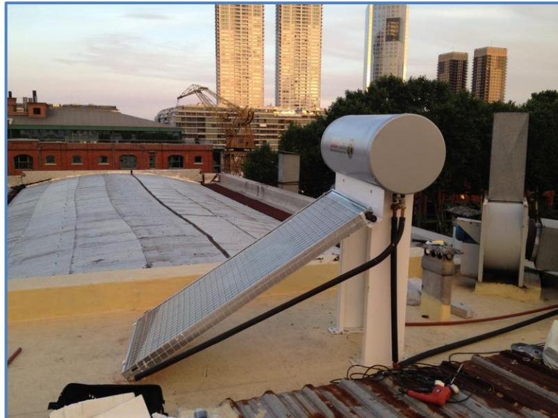
Figura 16 – Vista lateral del colector solar en el momento de la instalación.
