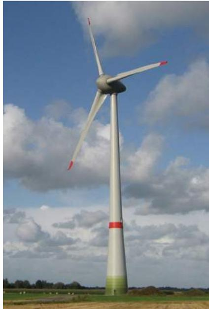
Figura 2: MW Enercon E126 turbina eólica. Altura de torre 135m, diámetro del rotor 126m.[5]
