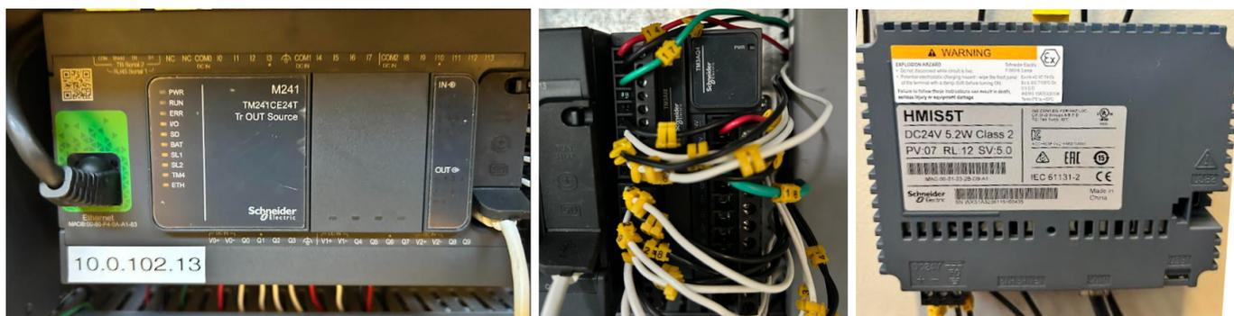
**Figura 7.1-1.** PLC Schneider Electric M241 utilizado, con sus módulos de I/O analógicos y su HMI.
