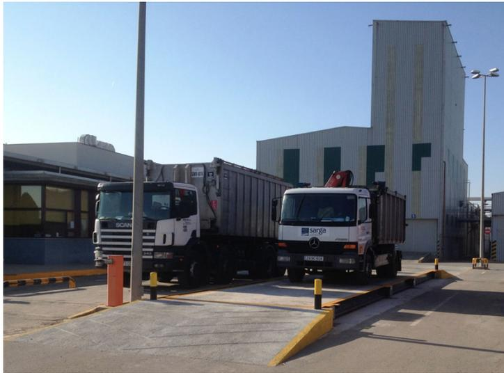
Figura 45: Balanza de camiones para el control de ingreso de materia prima.
