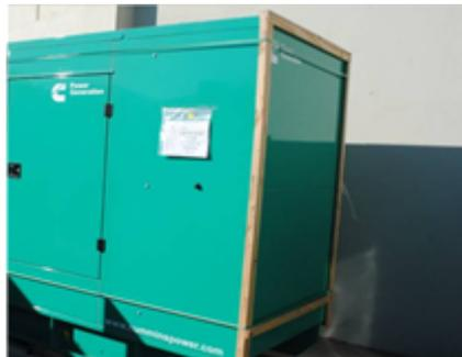
Figura 48: Grupo electrógeno para garantizar la operación ante cortes de suministro.
