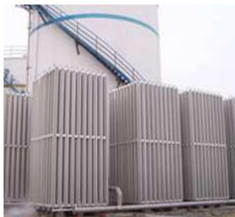
Figura VII-33. Estación Regasificadora
