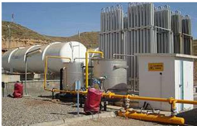
Figura VII-32. Estación Regasificadora
