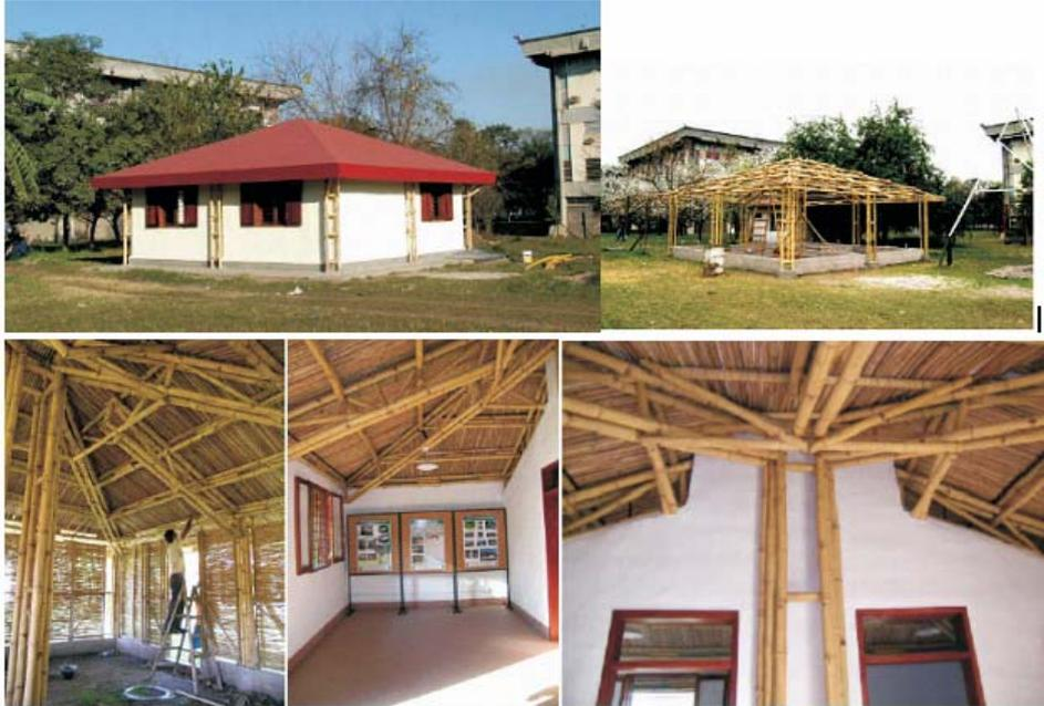
Fig. 4.5.1-8. Vivienda en bahareque de bambú encementado. Fuente Proyecto Bambú- UNT.
