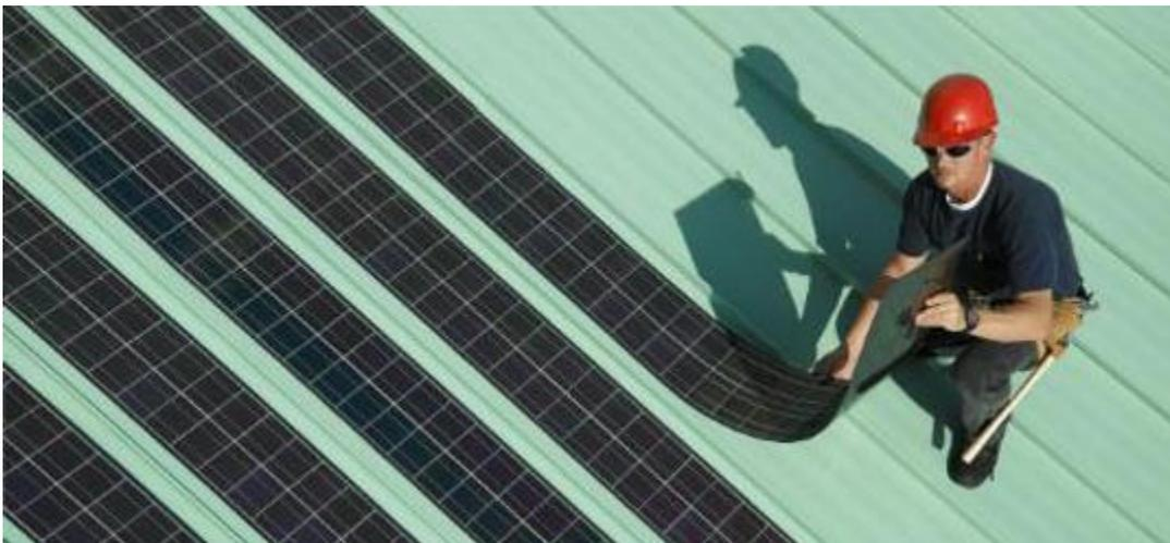
Ilustración 32. Paneles solares de láminas delgadas: Cobre-Indio-Galio-Selenio (CIGS). Fuente: Google Images.
