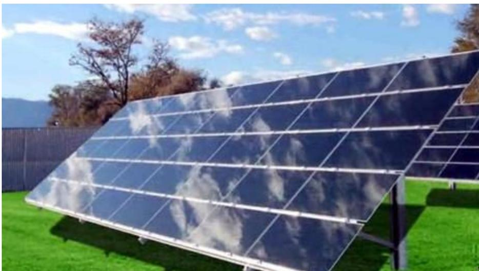
Ilustración 31. Paneles solares de láminas delgadas: Cadmio-Telurio (CdTe). Fuente: Google Images.
