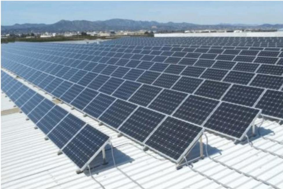
Ilustración 27. Paneles solares de silicio mono cristalino. Fuente: Google Images.
