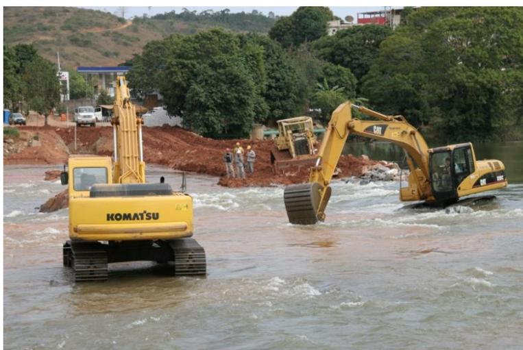
**Figura 2.18** – Equipos utilizados durante los trabajos de cruce a cielo abierto
