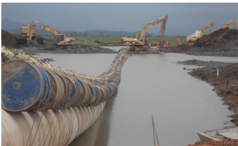
**Figura 2.21** – Equipos utilizados durante los trabajos de Push/Pull
