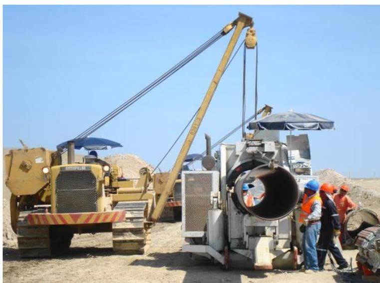
**Figura 2.10** – Equipos utilizados durante los trabajos de curvado
