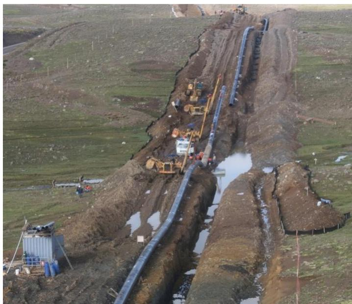
**Figura 4.2** – Trabajos de bajada en la línea regular con terreno inundado
