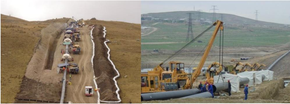
**Figura 2.13** – Equipos utilizados durante los trabajos de soldado
