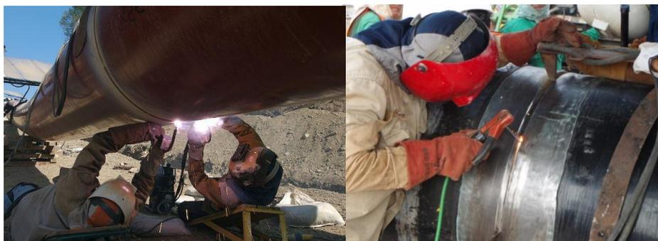
**Figura 2.11** – Trabajos de soldadura manual
