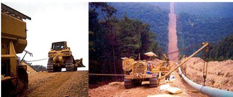
**Figura 4.3** – Trabajos de bajada realizados en una pendiente
