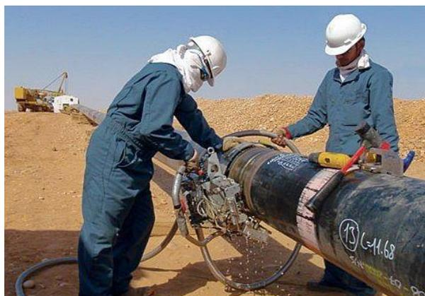
**Figura 2.13** – Equipo para ensayos de ultrasonido
