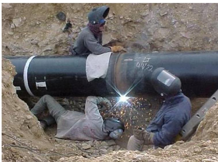
**Figura 2.22** – Cuadrilla ejecutando la soldadura de Tie-in.
