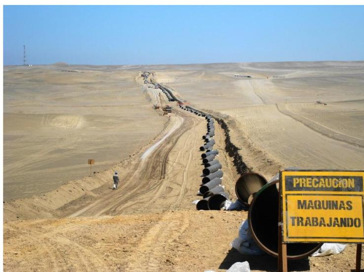
**Figura 2.8** – Tubería alineada a lo largo de la traza
