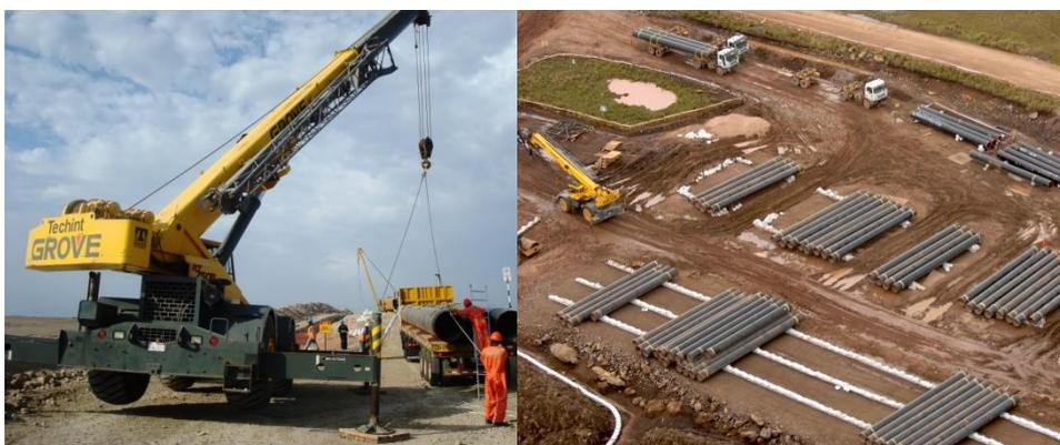
**Figura 2.9** – Equipos utilizados durante los trabajos de desfile
