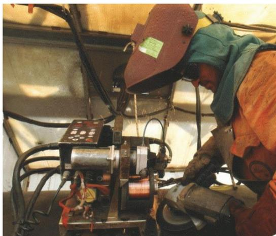
**Figura 2.12** – *Proceso de soldadura automática*
