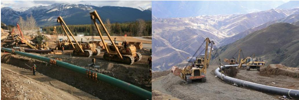
*Figura 2.16 – Equipos utilizados durante los trabajos de Bajada*
