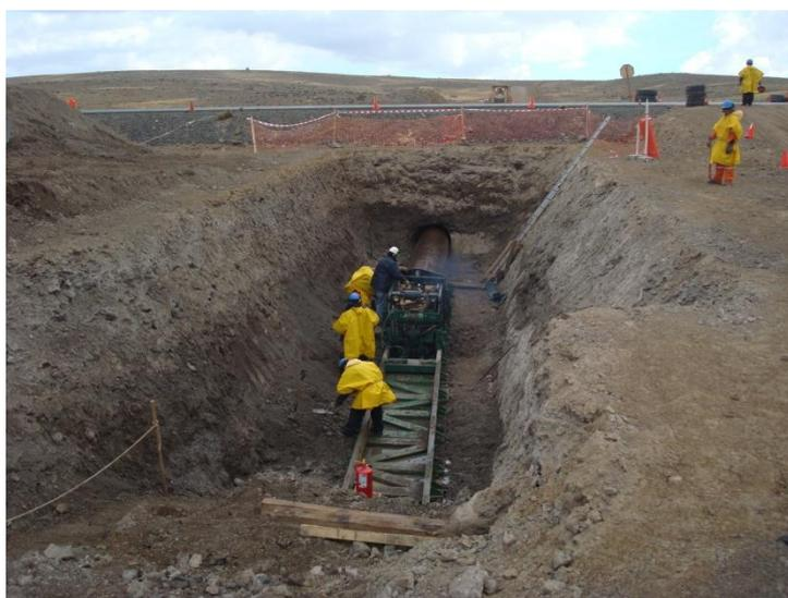
**Figura 2.20** – Método de Pipe Jacking
